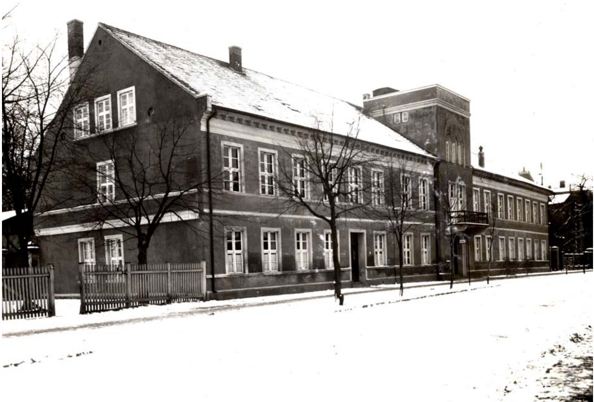
Fassadenumbau um 1930 (Stadtarchiv Greifswald).
